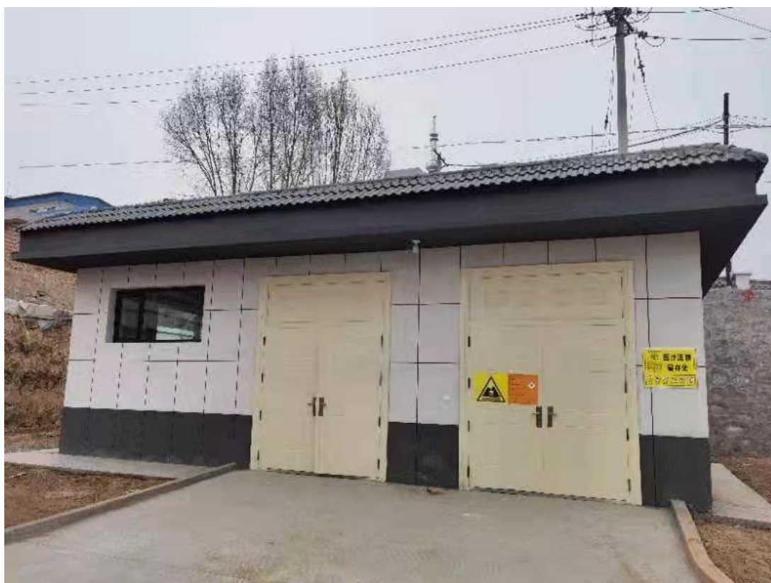
医院医废暂存间
